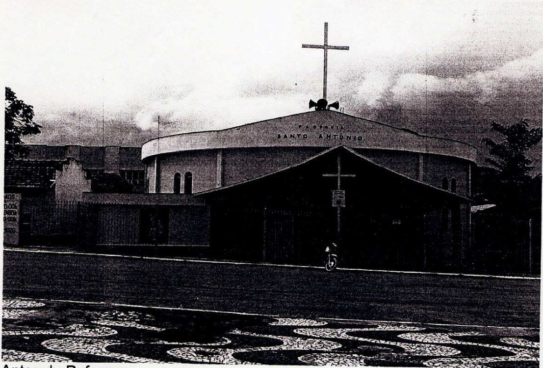
Antes da Reforma
